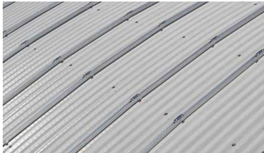
Elpo | Brixen - Italien Anlage: 88,83 kW | Solarbefestiger System
