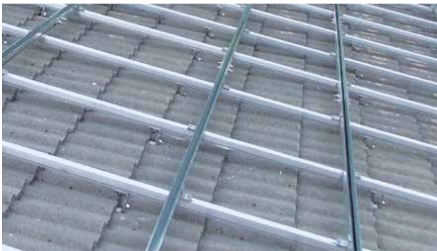
Elpo | Pfunders - Italien Anlage: 484,65 kW | Dachhaken Vario 2 im Kreuzverbund
